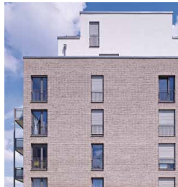
1.300 m 2 Klinkerriemchen umfasst der speziell für dieses Objekt entwickelte Architekturbrand No. 433 von STRÖHER. Dazu wurden 13.846 Eckwinkel gefertigt, um eine perfekte Mauerwerksoptik an der Fassade herzustellen.
