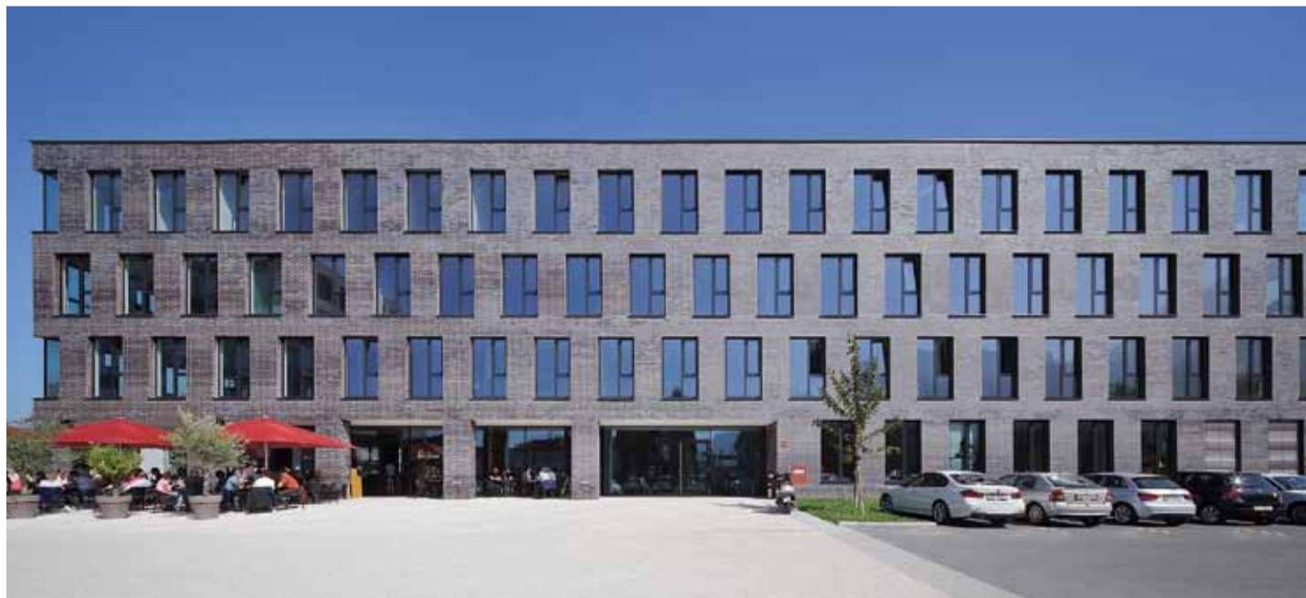
Wie schon bei Campus I wurde auf Wunsch von Aicher Architekten die Serienfarbe „336 metallic schwarz“ als spezieller Architekturbrand modifiziert. In Bauabschnitt 2 wurden 1.583 m 2 Riemchen verarbeitet.
