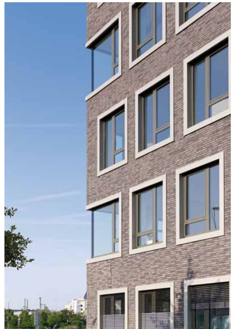
Die Fassade wurde mit 2.200 m 2 Klinkerriemchen im Dünnformat, 21.000 Eckwinkeln und 400 Sturzwinkeln auf WDVS hergestellt.
